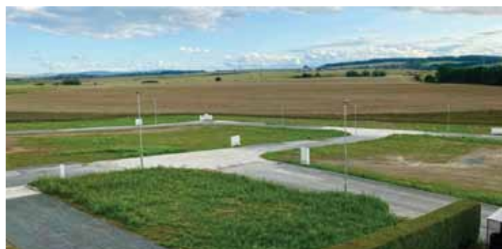
Budoucí nová čtvrť ve Dnešicích – Kameničky, zatím jako téměř „holá“ pláň, jen ulice a nutné sítě.
